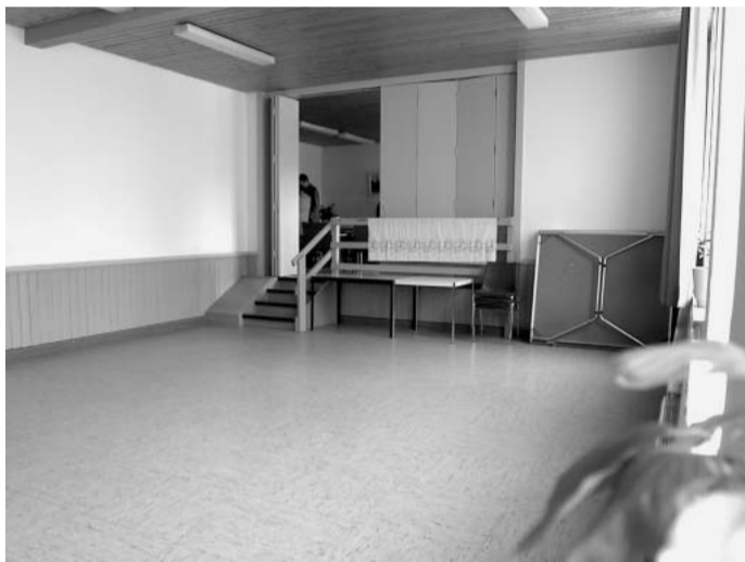
Der große Raum: Das Gebäude ist auch innen in einem guten Zustand, sagen Experten. Alles funktioniert.
